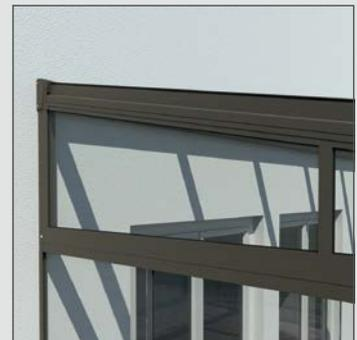
*Dreieckschluss mit Glashalte-/Wandanschlussprofil (C) und Mittelsteg (Option)*
