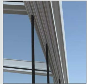
obere Führungsschiene, 3-spurig
